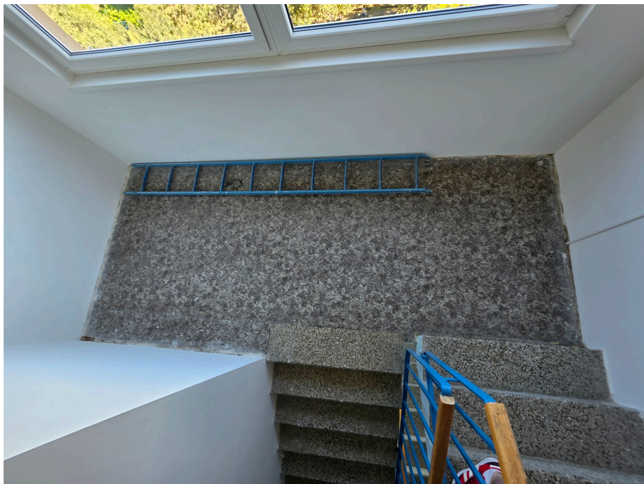
A3 - 859 6/7. p - výměna PVC a olištování
