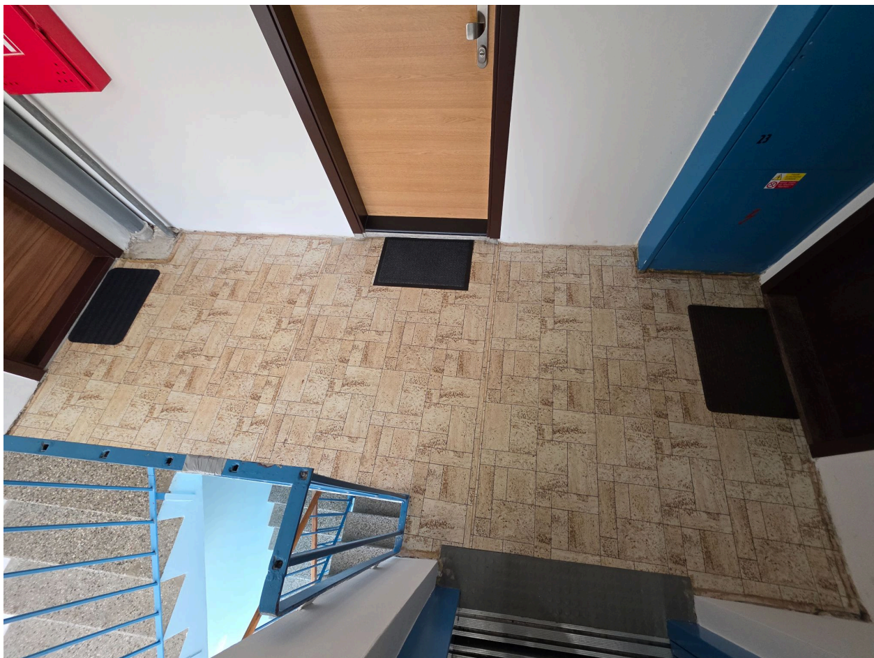
B1 - 860 7.p - výměna PVC a olištování
