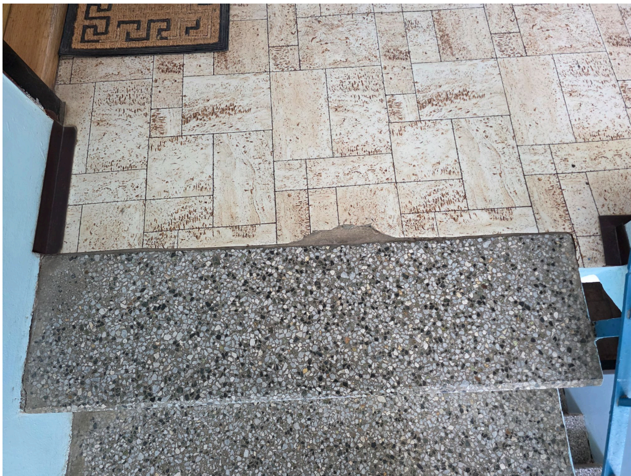
B7 - 860 1.p - výměna PVC a olištování
