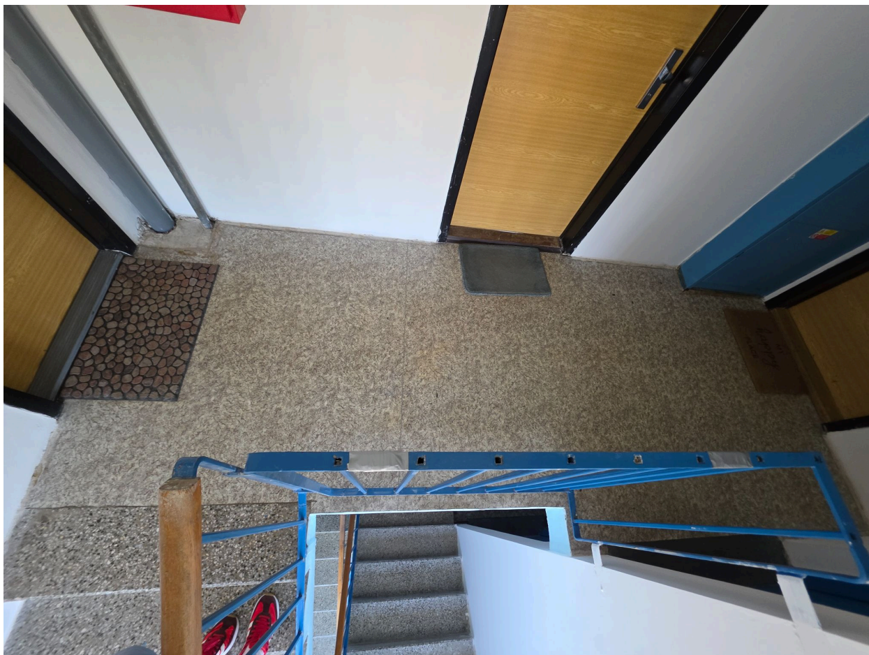
A1 - 859 7.p - výměna PVC a olištování
