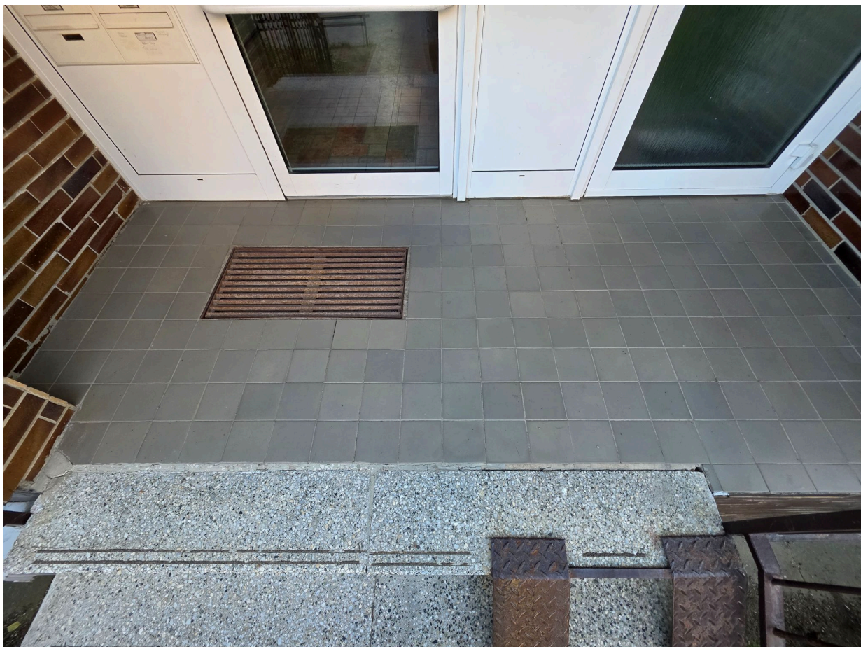
Vstupní lodžie vchodu 859
